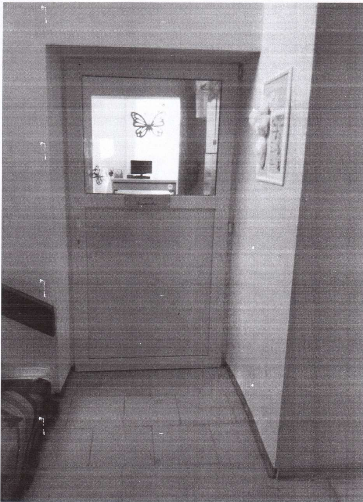
Фото 7. Вход, дверь в групповую комнату изнутри
